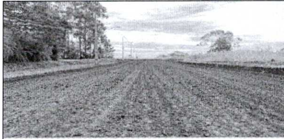
4 | REGULARIZAÇÃO DO SUBLEITO-RUA CARIRIS
