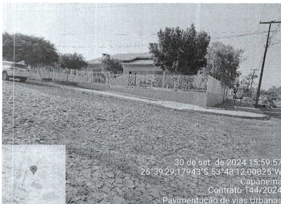
Figura 14- Rua Pará, serviços de urbanização.
