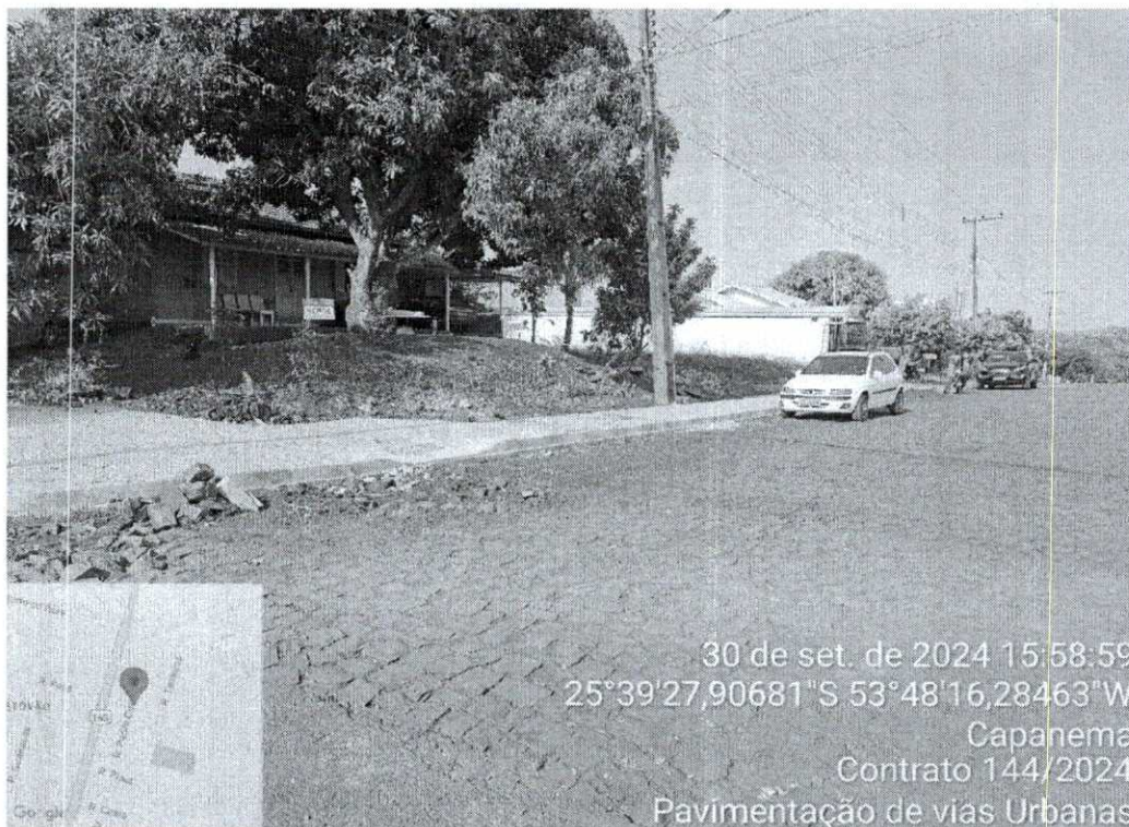
Figura 17- Rua Pará, serviços de urbanização.
