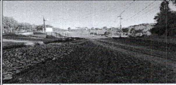
5 | REGULARIZAÇÃO DE SUBLEITO, MATERIAL SUB-BASE RUA CARIRIS
