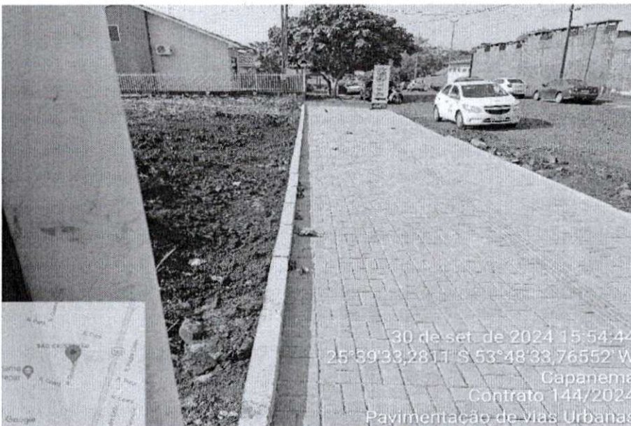
Figura 08- Rua Guairacás, serviços de urbanização.
