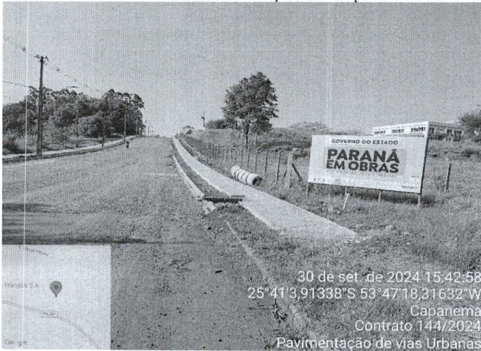
Figura 02- Rua Cariris, placa da obra serviços de urbanização, e base.
