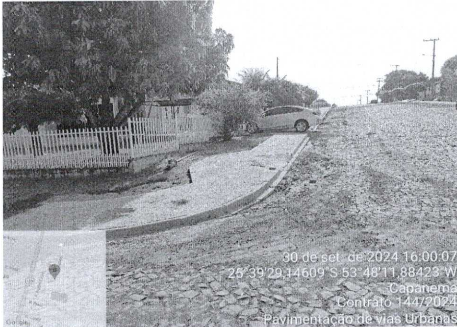
Figura 12- Rua Pará, serviços de urbanização.
