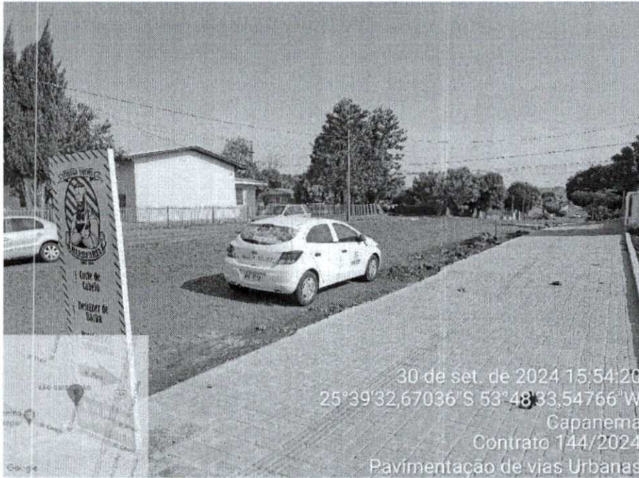
Figura 09- Rua Guairacás, serviços de urbanização.
