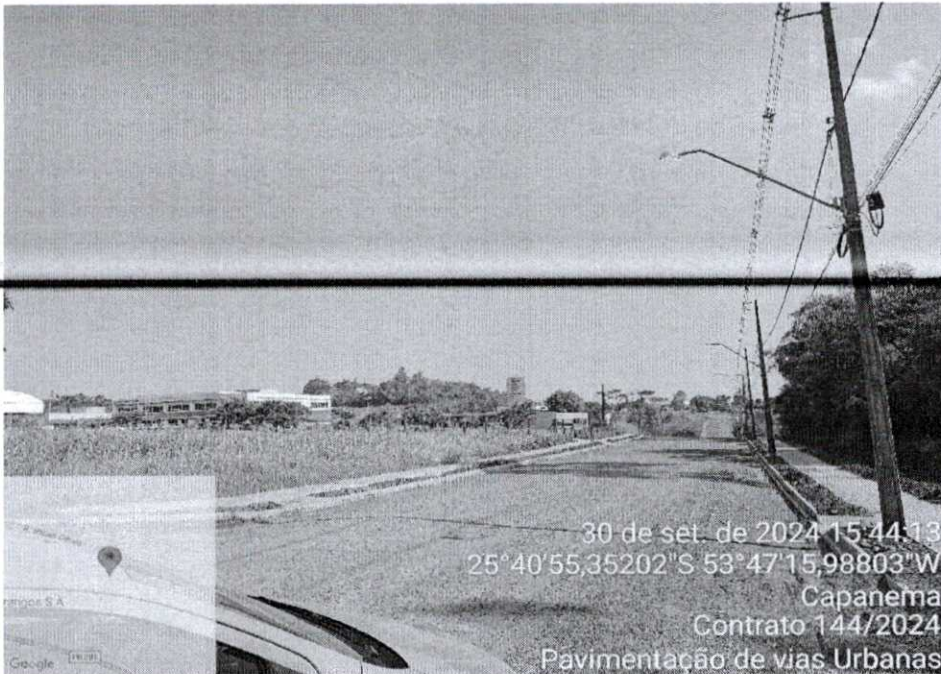
Figura 05- Rua Cariris, serviços de urbanização, e base.
