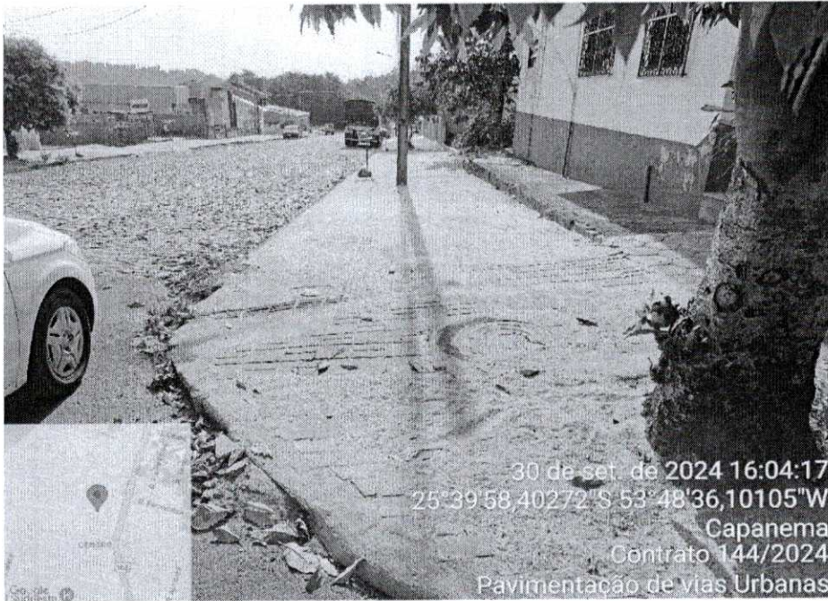
Figura 11- Rua Alagoas, serviços de urbanização.
