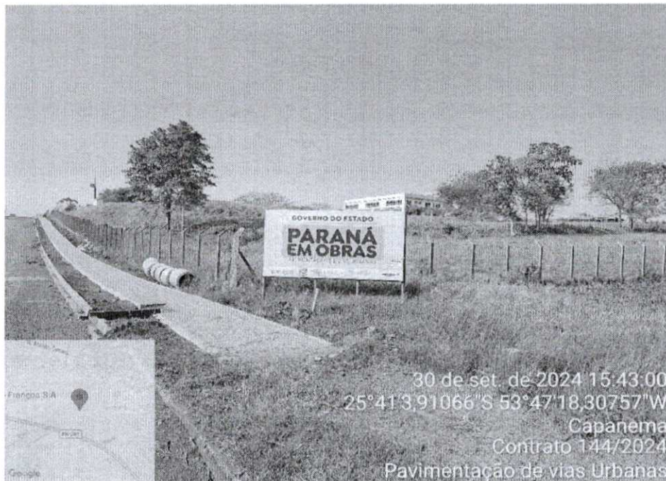
Figura 01- Rua Cariris, placa da obra serviços de urbanização.
