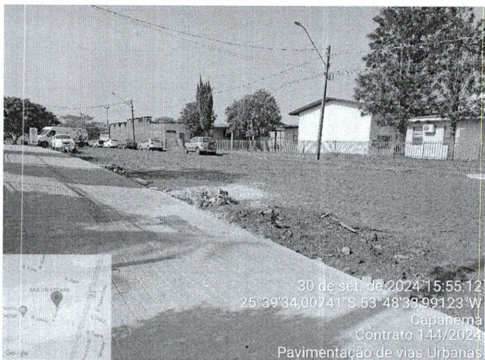
Figura 06- Rua Guairacás, serviços de urbanização.
